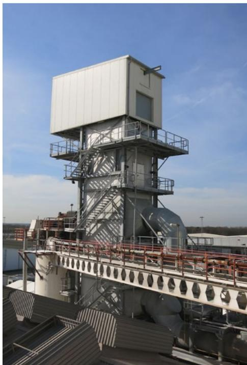
Abbildung 19: Praxisbeispiel für eine Gemengevorwärmung in der Behälterglasproduktion (350 tpd). Quelle: ZIPPE Industrieanlagen GmbH
