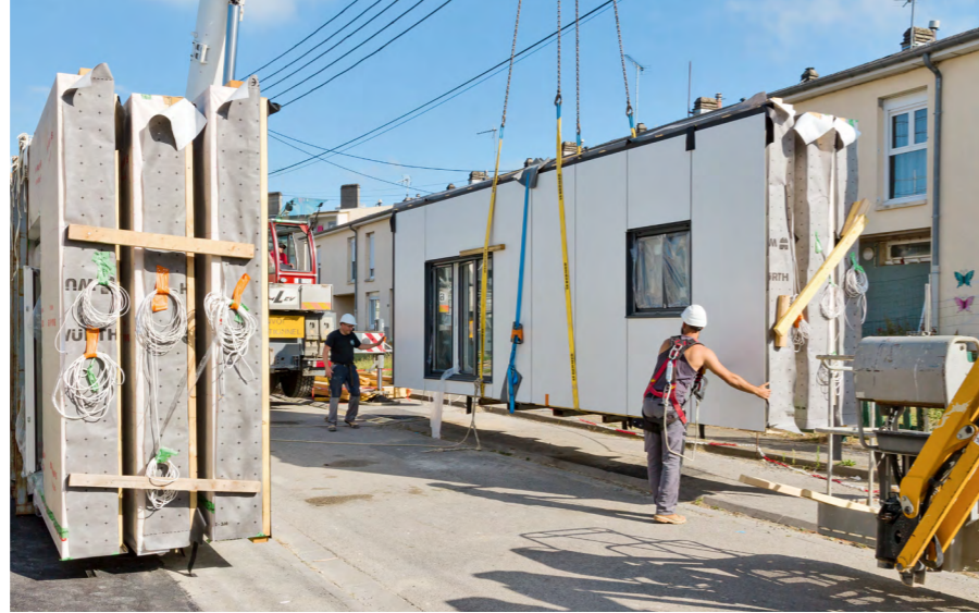
Gedämmte Fassaden und Dachteile werden vorgefertigt und müssen nur noch am Gebäude montiert werden: serielle Sanierung im französischen Longueau.
